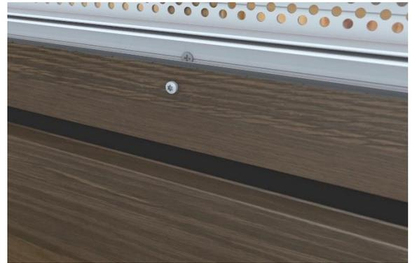
Une fois l'ensemble des lames posées, les baguettes de finitions pourront être clipsées sur les rails précédemment installés (H de dilatation, profil de ventilation haut, angles extérieur/intérieur et profil de finition).
