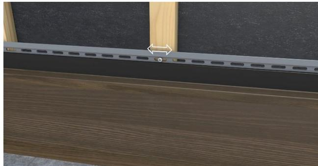
En effet, Il s'agira de ne pas brider les lames. Pour vérifier que le serrage de la vis est bon, il devra permettre à la lame de bardage de translater de droite à gauche et inversement. Une fois ces vérifications effectuées, il conviendra de replacer la vis au centre du trou oblong.
