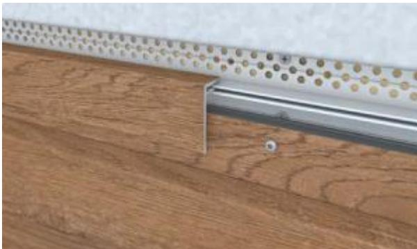
La grille anti-rongeur positionnée en partie basse assure l'entrée de l'air (1). Le profilé de ventilation haut assure quant à lui la sortie de l'air(2).
