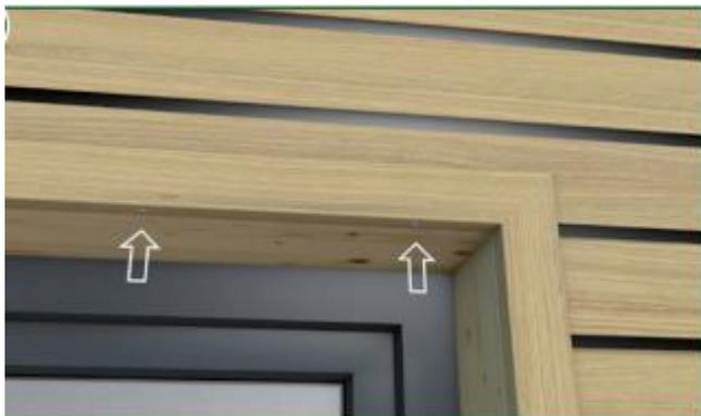
Dans la zone située au-dessus de la fenêtre ou de la porte, il faut prévoir, afin d'assurer un écoulement correct de l'eau de pluie des trous de drainage de 6 mm tous les 20 cm.
