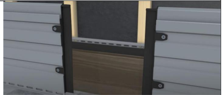
En premier lieu, il faudra réaliser un point de blocage au milieu de la 1<sup>ère</sup> lame (hors trou existant). Cela permettra de contenir la dilatation de part et d'autre de ce point fixe.
