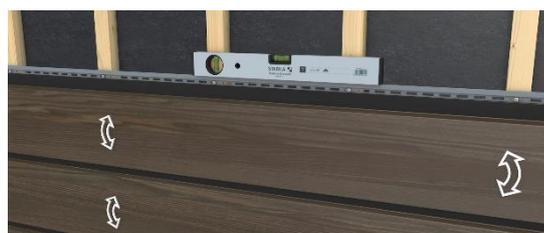
Il convient également de respecter les règles de serrage pour permettre au bardage de se dilater sans contraintes mécaniques. En effet, lors du vissage des vis pour la fixation des lames, le vissage devra se faire au milieu des trous oblongs. Les vis ne devront pas être serrées pour ne pas mettre le bardage en contrainte.
