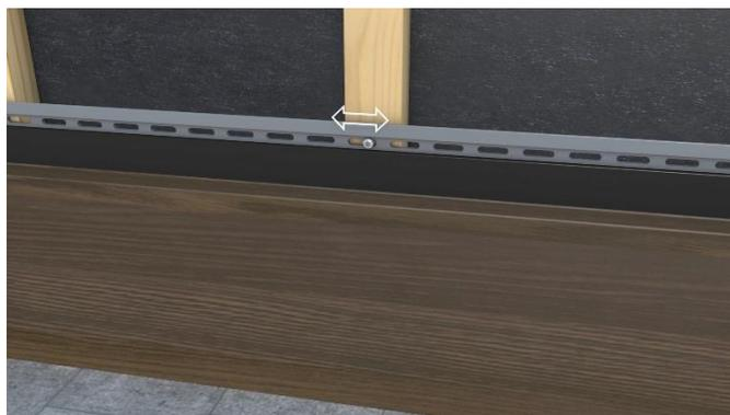
La vis devra être mise d'équerre et un jeu de 0.5mm respecté entre la vis et la lame de bardage.
