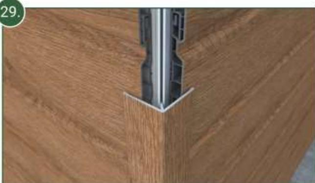
29. Scier si nécessaire les parties supérieures des accessoires à la longueur souhaitée puis les clipser sur les parties inférieures préalablement montées.
