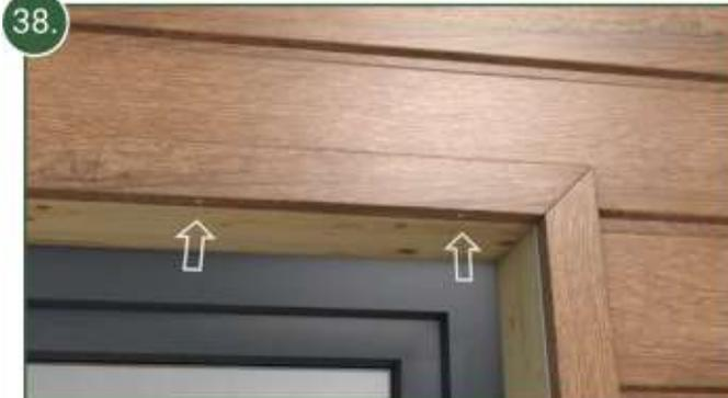
Dans la zone située au-dessous de la fenêtre, il faut prévoir tous les 20 cm des trous de drainage de 6 mm de diamètre dans le profilé de finition afin d'assurer l'écoulement des eaux de pluie.
