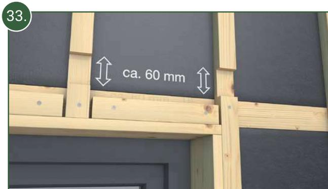
Au droit des ouvrants, il conviendra de raboter les chevrons (minimum 60 mm) ou de les démarrer plus haut, pour permettre la ventilation à l'arrière des lames.
