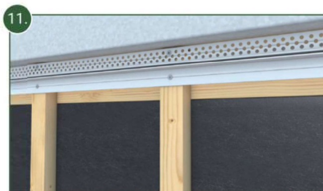
11. Visser, dans la rainure prévue, la partie inférieure du profil de ventilation (BAR_PV) sur la partie supérieure de la façade.
