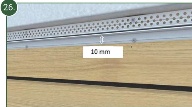
26. La distance entre la partie supérieure de la dernière lame et la rainure de clipsage du profilé de ventilation doit être de 10 mm. (idem jeu des lames avec les profils de finition).
