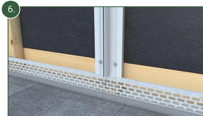
6. Procéder si nécessaire (longueur de façade dépassant 6 mètres) de la même manière avec la partie inférieure du H de dilatation (BAR\_H)
