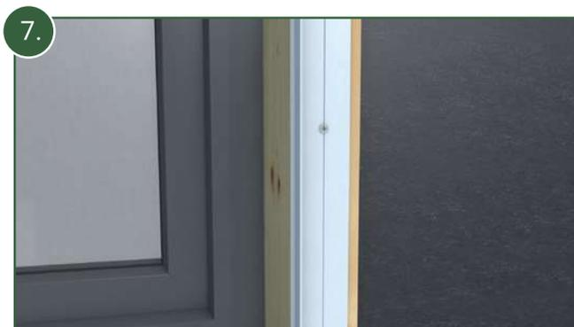
7. Visser maintenant les parties inférieures des profilés de finition (BAR\_PF) sur les extrémités gauche et droite de la façade
