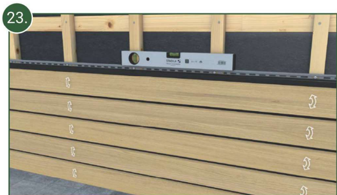
Il faut vérifier régulièrement le niveau des lames à l'aide d'un niveau à bulle.
