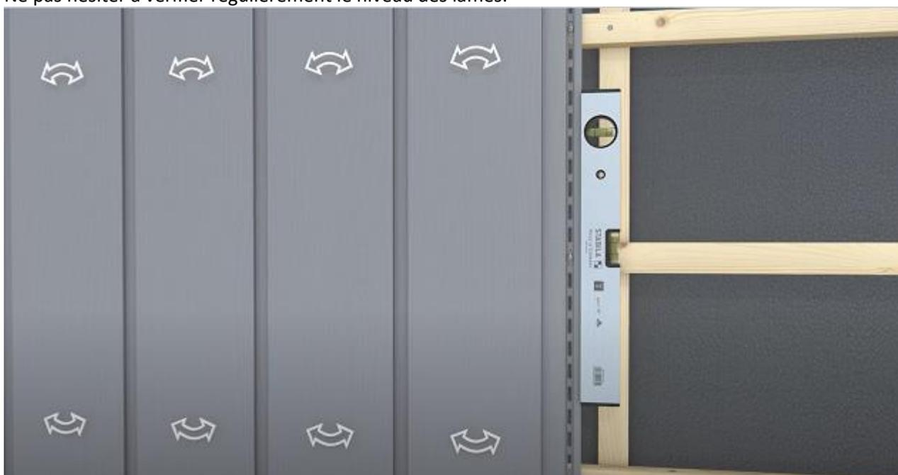
Il convient également de respecter les règles de serrage pour permettre au bardage de se dilater sans contraintes mécaniques. En effet, lors du vissage des vis pour la fixation des lames, le vissage devra se faire au milieu des trous oblongs. Les vis ne devront pas être serrées pour ne pas mettre le bardage en contrainte.
